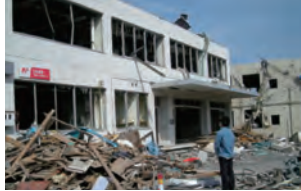
日本郵便 女川集配センター
