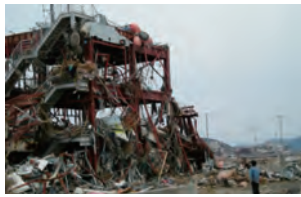
南三陸町 防災対策庁舎
